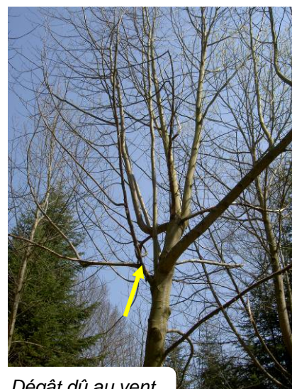
Dégât dû au vent
